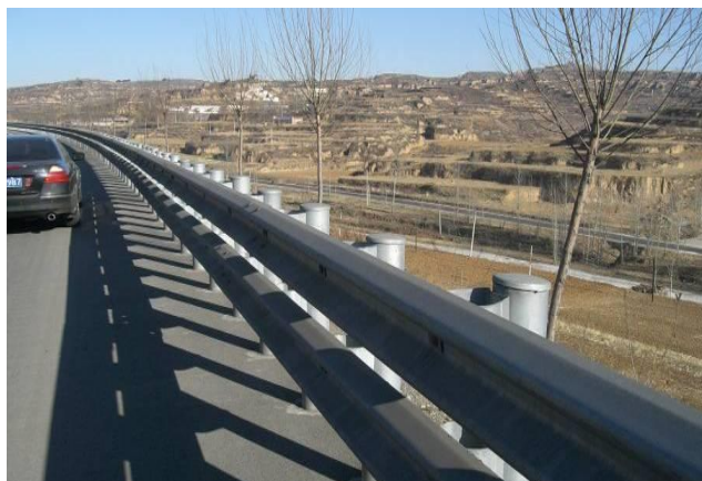
图 6.1 防护栏强化实例（山西太长高速公路）
